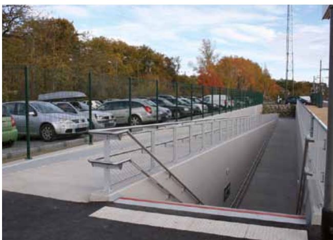
Le souterrain pour les piétons à la gare de Bourron-Marlotte.
