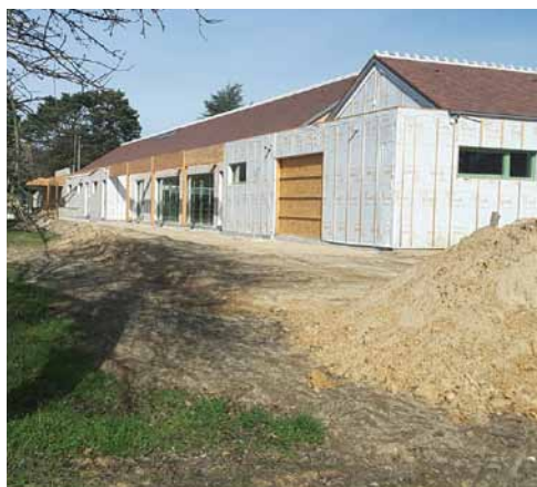
Les cloisonnements intérieurs du restaurant scolaire, les terrasses extérieures et le parking
