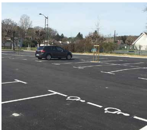
Le parking central et le revêtement de l'aire du skate parc
